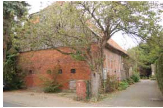
Abb. 4.12: Das Haus Bergmann in Gehrde steht seit vielen Jahren leer
