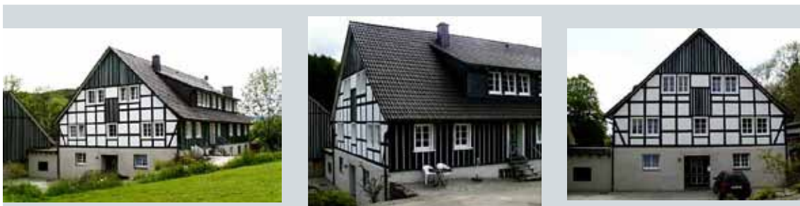
Abb. 6.24. Außenwohngruppe Hof Belke Niederhelden 2001 (Quelle: ARCHITEKTEN BECKMANN (Hrsg.), 2001: Außenwohngruppe Hof Belke Niederhelden (2001). Umbau und Ausbau eines Bauernhofes zur Außenwohngruppe "Hof Belke Niederhelden" für das Josefshaus Olpe. Stand: 2010-08-15, http://www.architekten-beckmann.com/bau-schulen/hof-belke-niederhelden.php )
