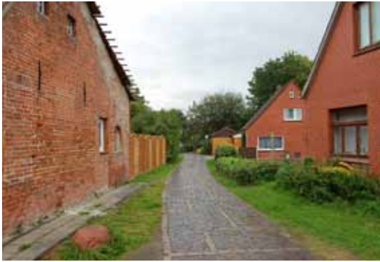
Abb. 4.60: Der Ortskern von Pewsum ist durchzogen von einem dichten Netz aus Fußwegen
