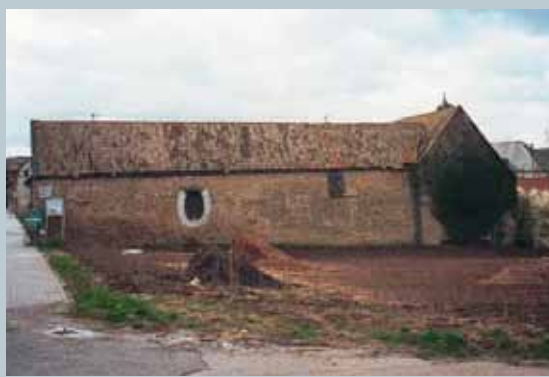
Kelterhaus vor dem Umbau 1994 im Nordwesten
