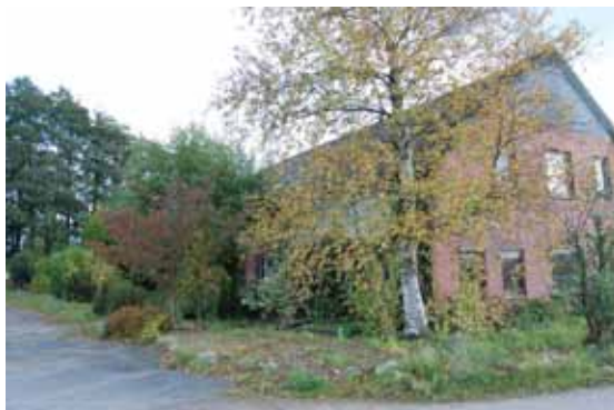
Abb. 4.43: Leer stehende Gaststätte am Hadelner Kanal
