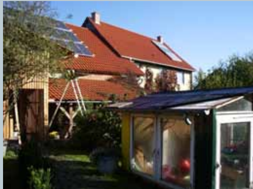
Rückseite der Werkstatt und des Wohnhauses 2009
