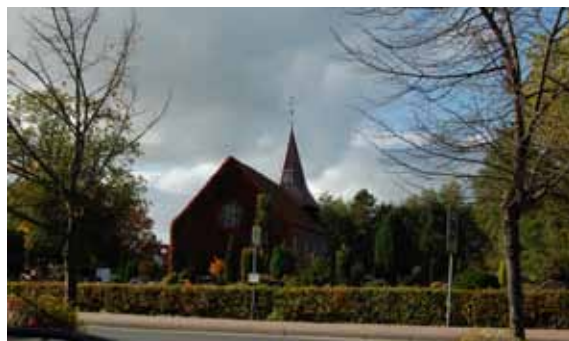
Abb. 4.41: Kirche in Odisheim, in diesem Bereich befinden sich die zentralen Einrichtungen
