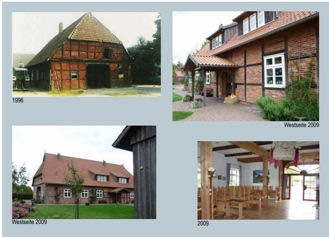
Abb. 6.13. Das Dorfgemeinschaftshaus Bockelskamp-Flackenhorst (Quelle (oben links): POTRATZ, S. (Hrsg.), 2010: Dorfgemeinschaftshaus Bockelskamp-Flackenhorst. Das Haus vor dem Abbau. Stand: 2010-07-29, http://www.bockelskamp.de/html/dgh_bilder_0.html )
