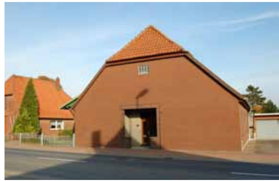
Abb. 4.32: Gebäude an der Bundesstraße
