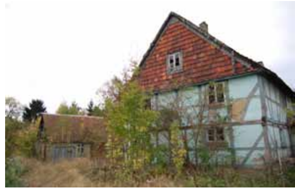
Abb.4.38: Leer stehendes Gebäude in Lobmachtersen
