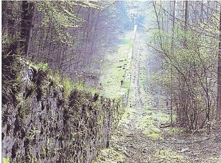
Abb. 2: Die Sauerparkmauer verläuft steil bergauf und bergab und überwindet dabei Höhenunterschiede zwischen 90 m ü. NN im Nordosten und 378 m ü. NN auf dem Nesselberg im Süden
