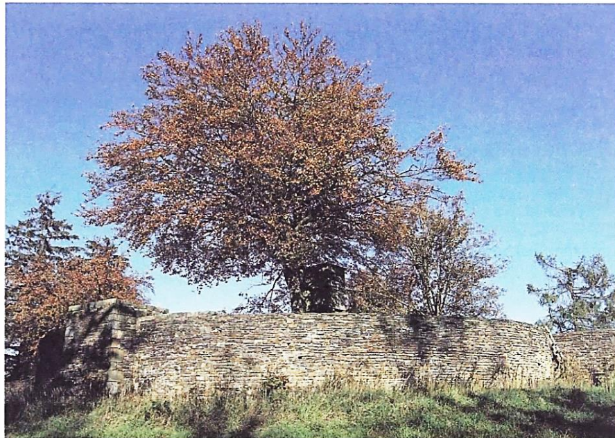
Abb. 3: An der »Waidmannsruh« auf der Höhe des Nesselberges wurde die Sauerparkmauer in den 1980er Jahren vorbildlich saniert
