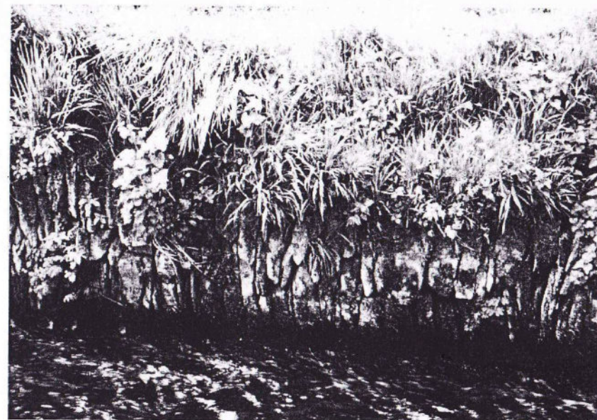
Abb. 2: Steckmauern wie diese aus schiefriger Grauwacke sind besonders gut zur Ufersicherung geeignet. An der Lenne in Lenne, 1995 (Foto: Frauke Brinkel)
