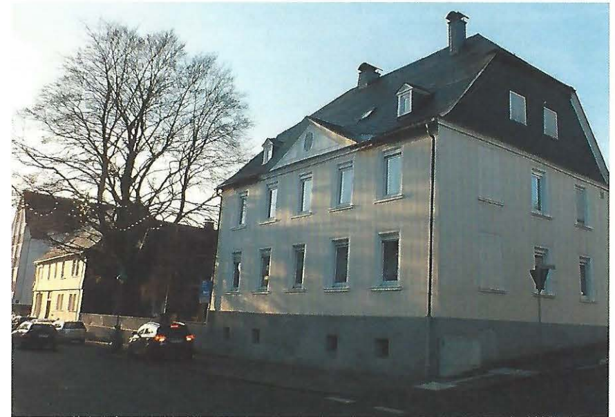
Abb. 4: Wesentliche Merkmale des repräsentativen Bürgerhauses Westfälische Straße 43 sind nach wie vor erhalten, so der flache Zwerchgiebel mit „Ochsenauge“ und das geschlossene Kellergeschoss.
